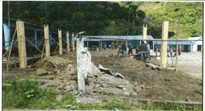
Foto 2: SUSTITUCION DE ESTRUCTURA DE TECHO
