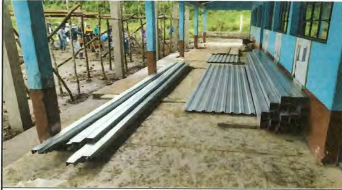
Foto1: SUSTITUCION DE ENTECHADO DE AULAS
