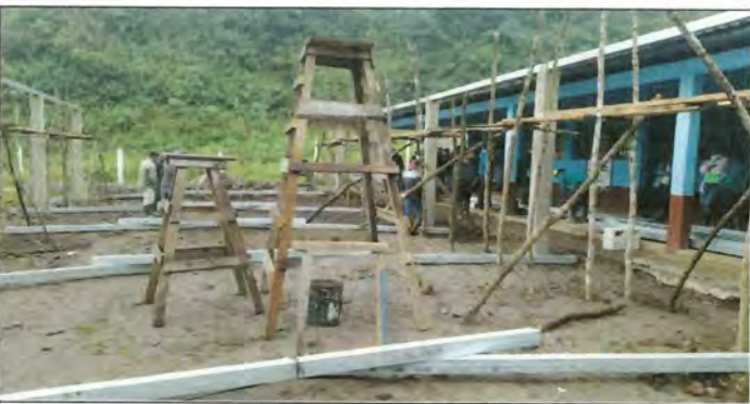
Foto 5: SUSTITUCION DE ESTRUCTURA DE TECHO
